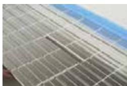
die flächenelemente vollständig und fugendicht verlegen. erforderliche zwischenstücke können mühelos abgelängt und in der flächenmitte eingefügt werden.
