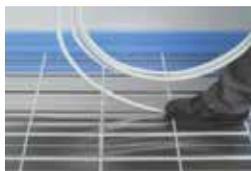
das heizrohr vom verteiler aus beginnend in die speziellen - führungen der wärmeleitlamellen einbringen. die nutzung einer abwickelvorrichtung, erleichtert die verlegung des heizrohres. als heizrohre, sind nur bavaria-press rohre mit der dimension 16 x 2,0 mm zu verwenden.
