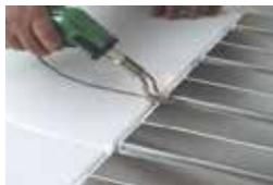
individuelle rohrführungen z.b. vor dem heizkreisverteiler oder bei einbauten, usw. können mit dem heißschneidegerät nachträglich ausgeschnitten werden.
