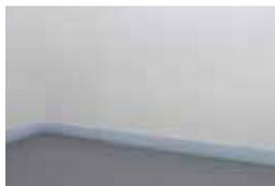
den randdämmstreifen entlang der wände, säulen oder treppen auf ebener und besenreiner rohdecke fixieren, ggf. eine trennlage bzw. feuchtigkeitssperre einbauen.
